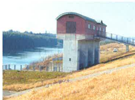
<境川排水機場>
