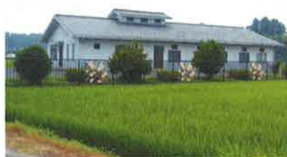
<上国井地区集落排水事業・処理センター>
