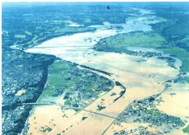
<昭和61年水害：千歳橋上空から国田、飯富方面>
